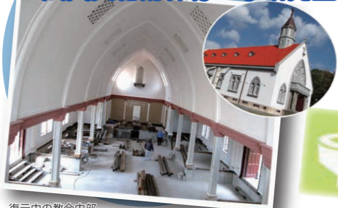
復元中の教会内部
